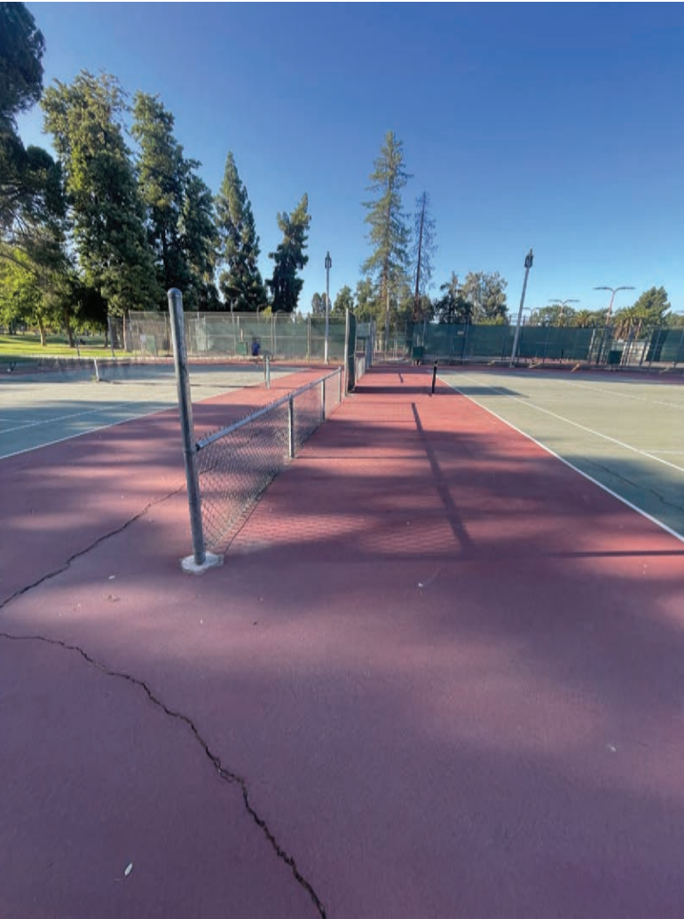
SURFACE DAMAGE / CRACKING DAÑOS DE LA SUPERFICIE / GRIETAS
