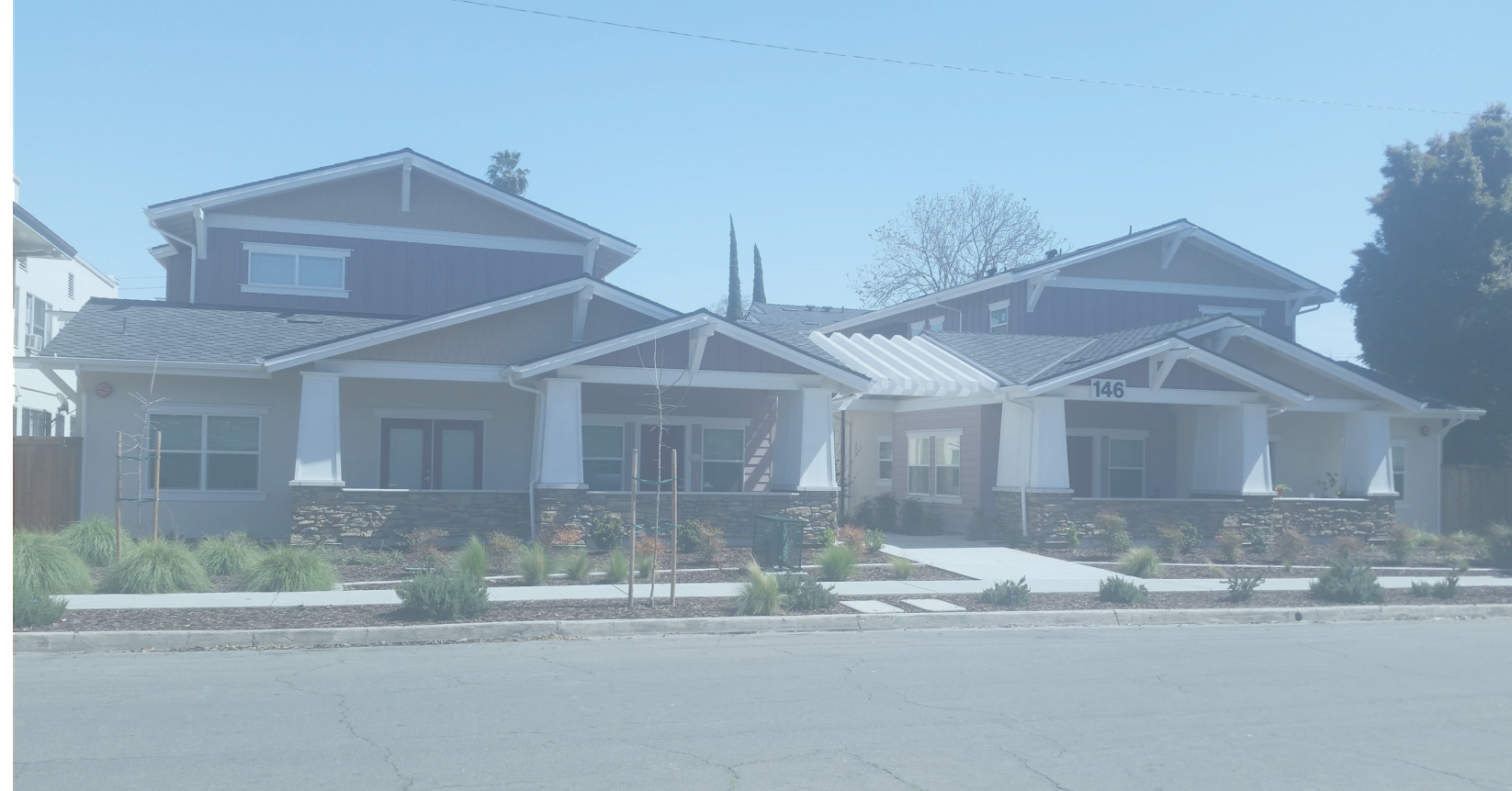
1406 N. Glenn HOME Project
