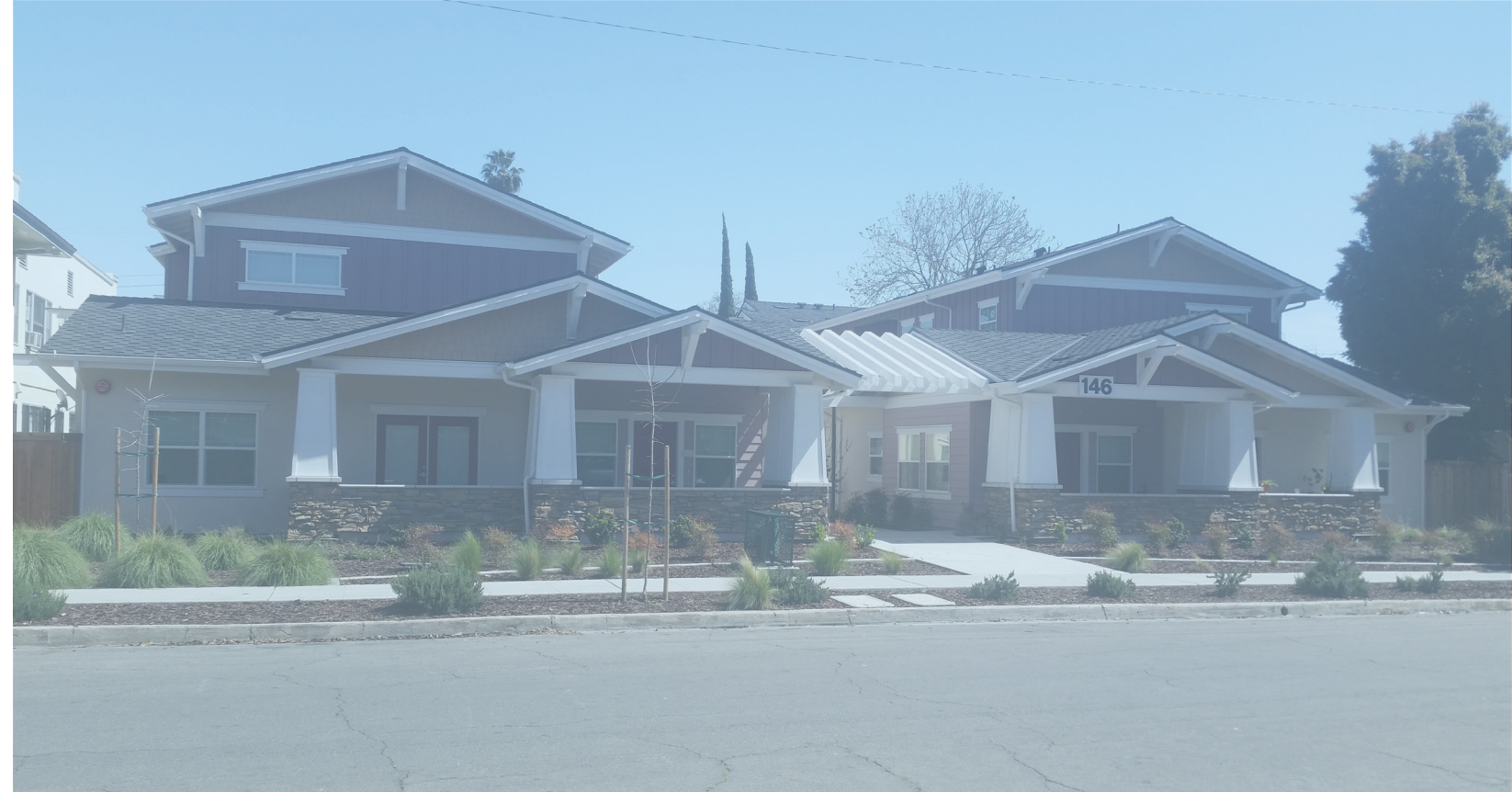
146 N. Glenn HOME Project
